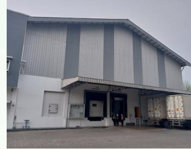
Cold Storage dan tempat loading container ekspor
